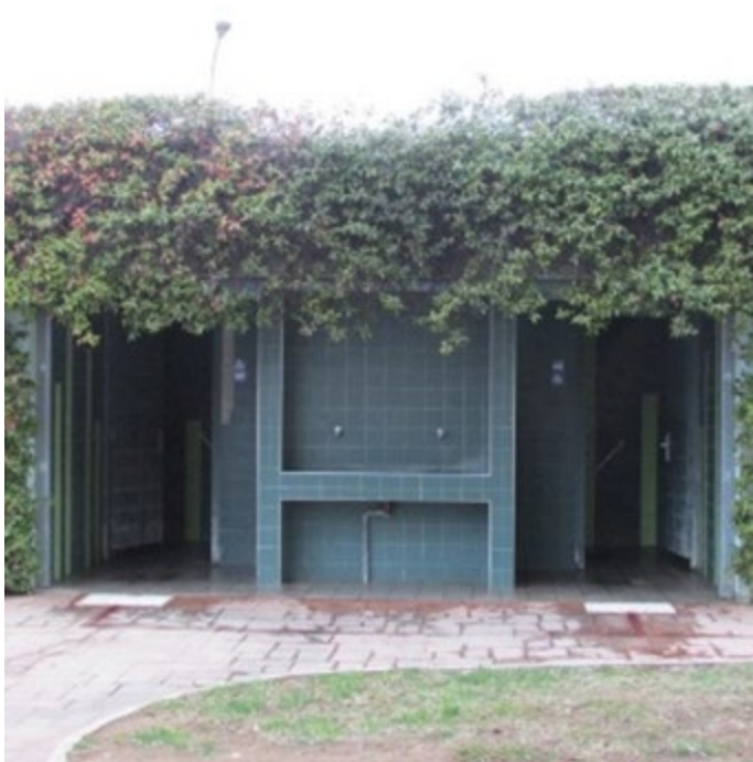
Deux WC PMR au niveau du parking.
